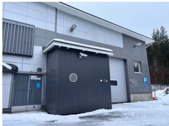
Kuva 1. Tuulikaappi ei ole suunnitelmassa esteetön. Pinkillä sähköisten ovenavauspainikkeiden (seinässä) paikat. Punaisella kulunvalvonnan paikka (viereisessä ovela)
